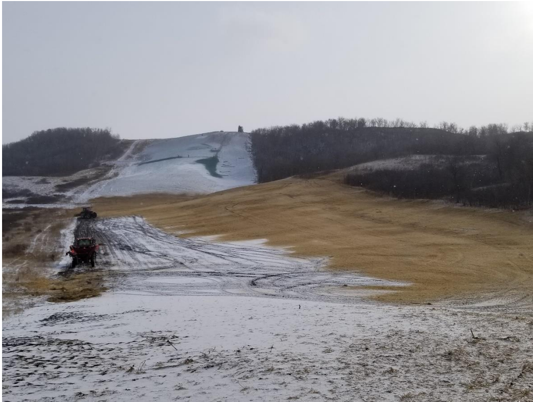
Hydro Mulching on the Qu'Appelle Valley slope.
